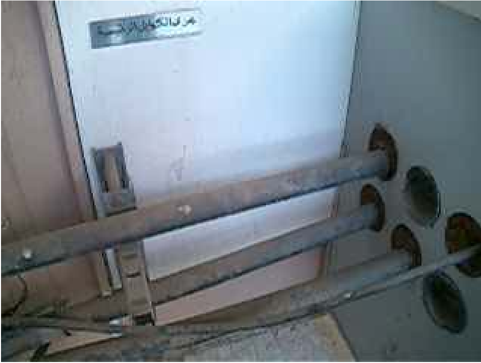
شكل (٦) يوضح كيفية خروج الكيابل من حوائط غرفة التفتيش
